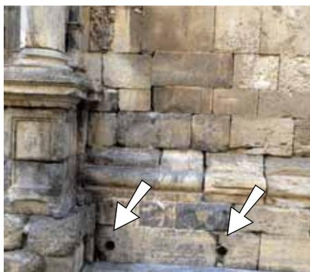
figura 42 - Para evitar este deterioro del edificio, los bloques más afectados fueron sustituidos y se montaron *respiraderos* (indicados con flechas) para interferir en el proceso del ascenso capilar de la humedad.
